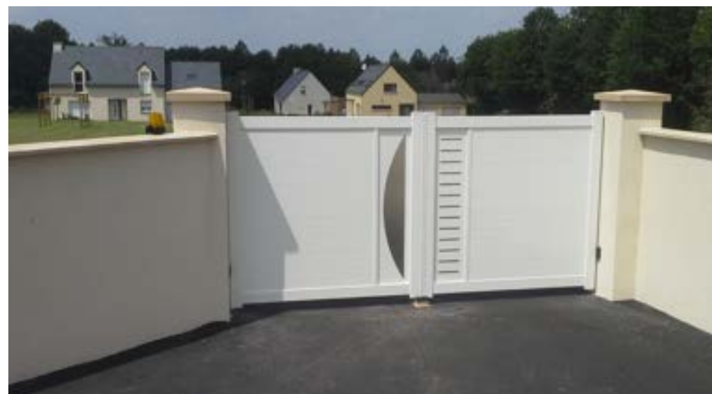
⌘ Harmonisation portail et porte d'entrée
